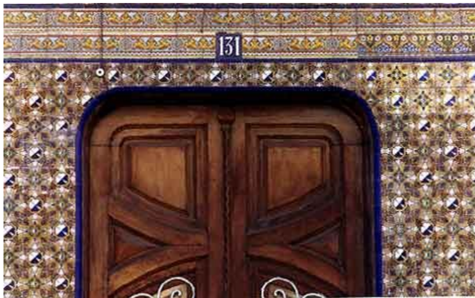
Illustration 2: Detalle de revestimiento completo de fachada y piezas complementarias con un diseño historicista
