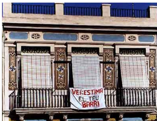
Illustration 5: Revestimiento de paños de fachada con gres porcelánico tipo Nolla
