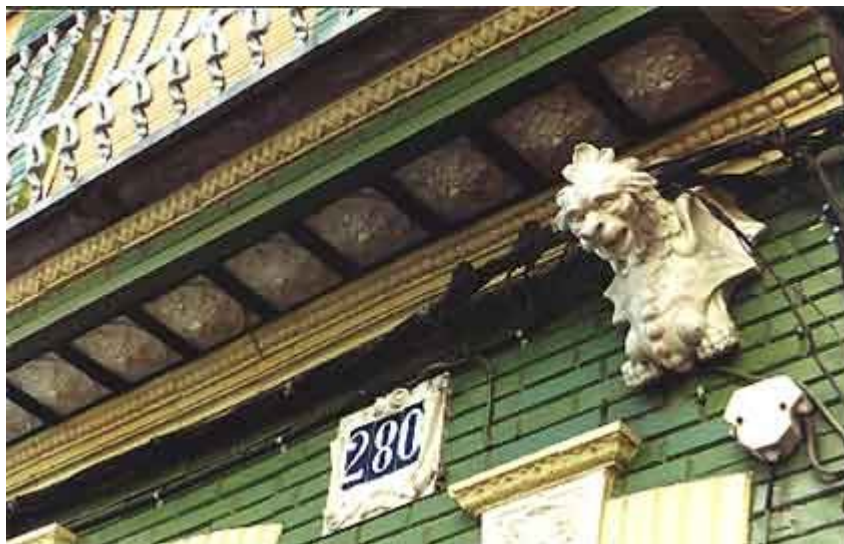
Illustration 6: Sotabalcón, molduras, placas de señalización, dovela y ménsula de loza
